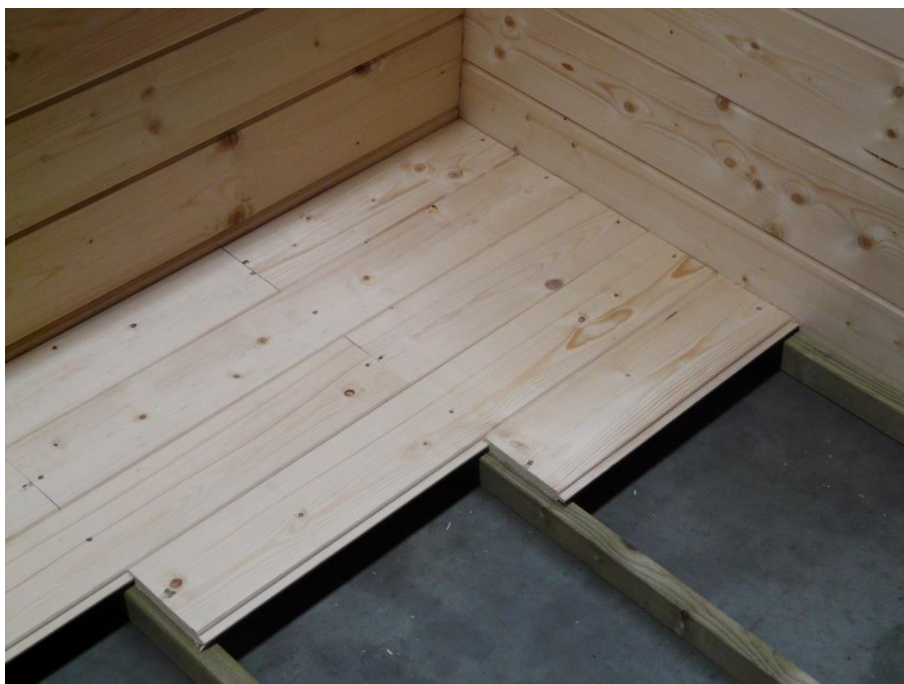
stavba na trámech umístěných na zemních vrutech - detail
